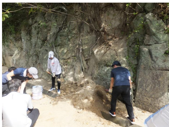
土砂をとって土のう袋に詰める学生
